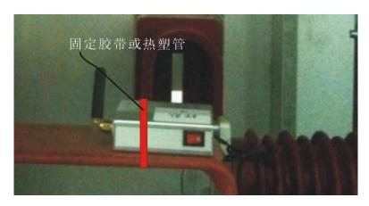
2、如果测量的是触头温度,或者是电缆搭界头的温度。此时的温度测量发射模块带有一根长度为 30CM 的高温导线,温度探头接在这条高温导线上(导线的耐受温度为 250°,导线可以接触铜排);安装分下面几个步骤:1、先把温度探头(也就是导线头上的不锈钢圆柱)安装到要测温度点上,温度探头要充分和要测量温度点的金属部分接触(不一定要按装在特定的点上,在点附近就可以了,因为金属的热传导性是很好的,短距离内温度基本相同。譬如要测量断路器动触头的温度,就没有必要非把点放在动触头的莲花头里面去,把测温点放到静触头处就可以了)。下图为测量断路器触头温度时的安装照片:
